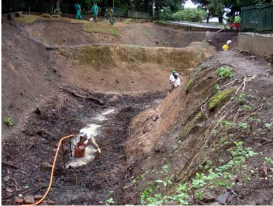
Figura 11 - Remoção da água acumulada após chuva.
